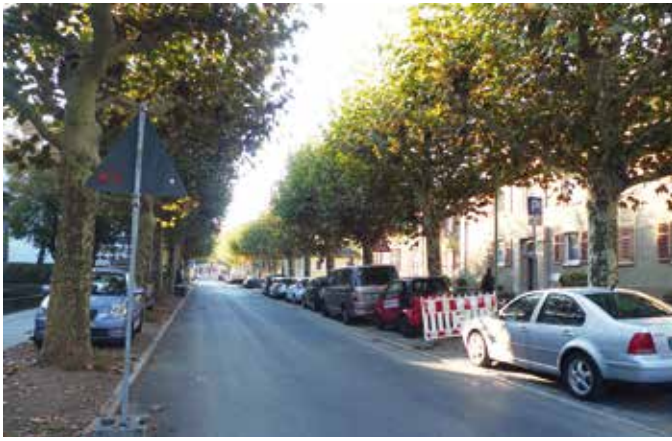
Die Sanierung ist fast fertig
