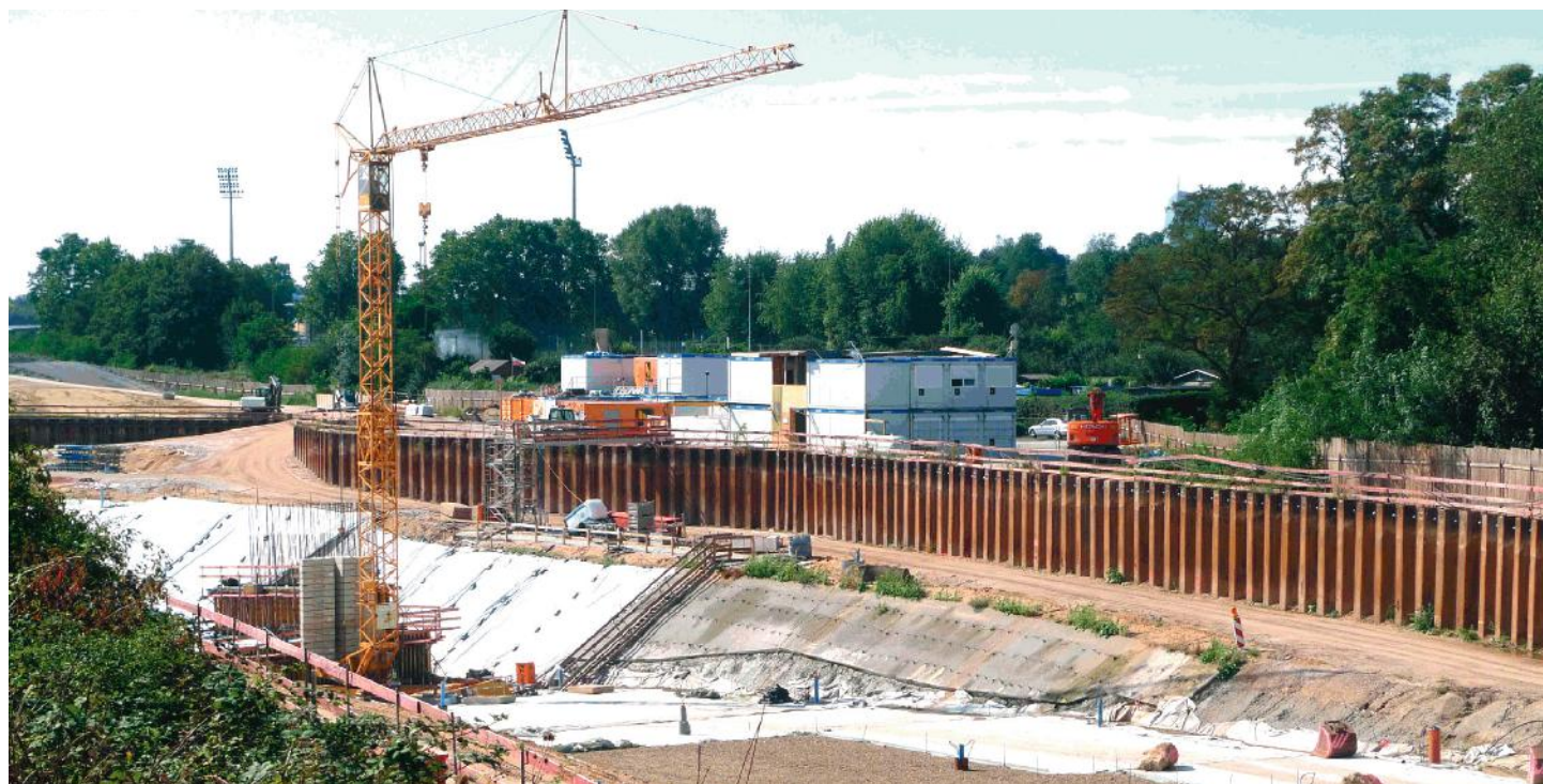
Baustelle am Erlenbruchdreieck, September 2015
