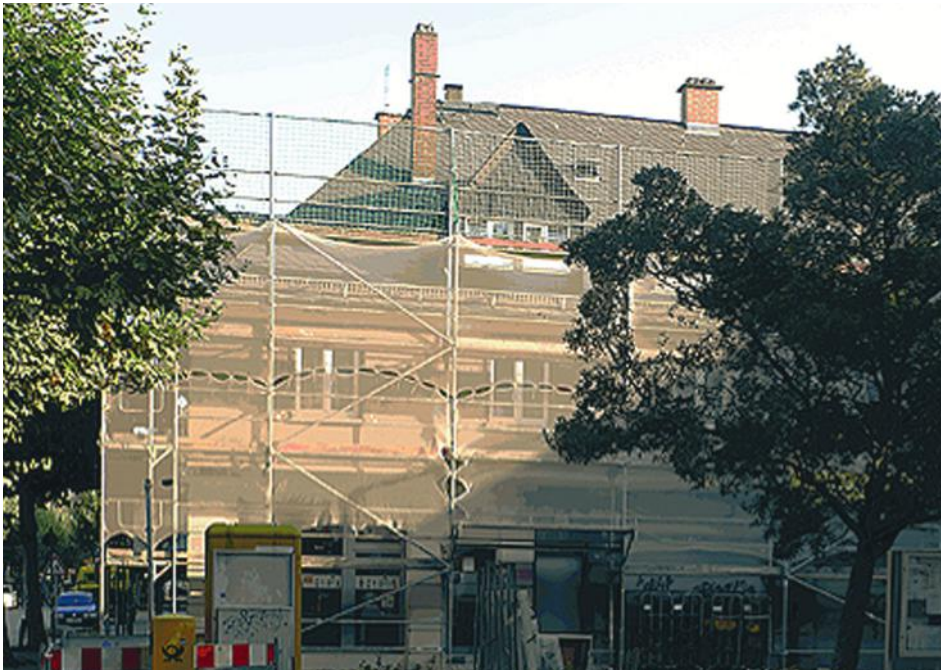
Sanierungsarbeiten in der Raiffeisenstraße
