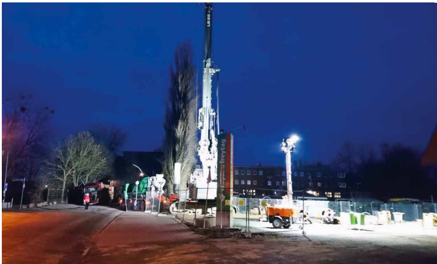
Auch im Dunkeln wird weitergebaut.
